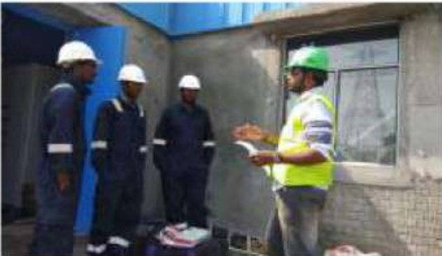
HVDC Pugalur (GIS ACDB)
